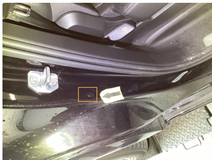
1.5 Bulk med lakkskade. Urført
