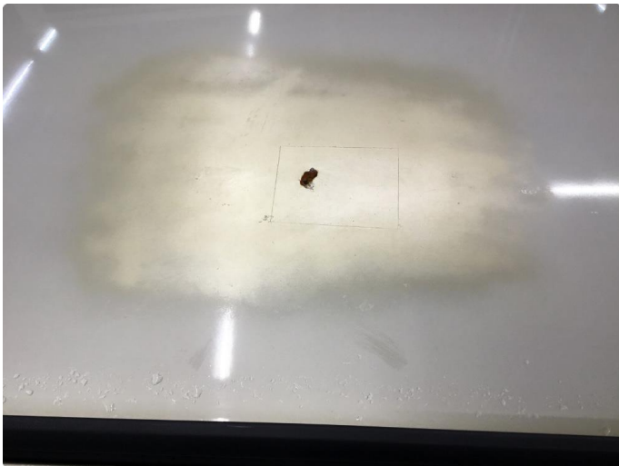
1.1 Ufagmessig utført arbeid
