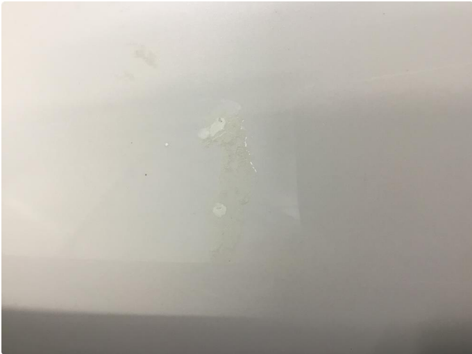
1.3 Ufagmessig utført arbeid
