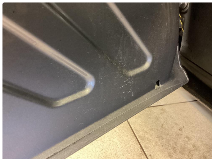
1.1 Rust i fals
