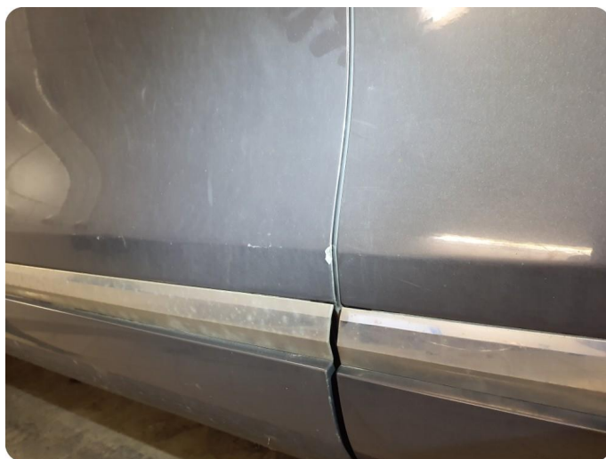
2.1 Generelt mye bruksslitasje
