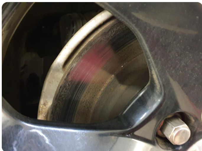
5.1 Rust Påbegynende rust. Må bruke bremses
