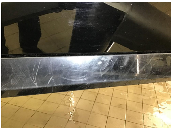
1.6 Noe bruksmerker på kanaler, poleres.
