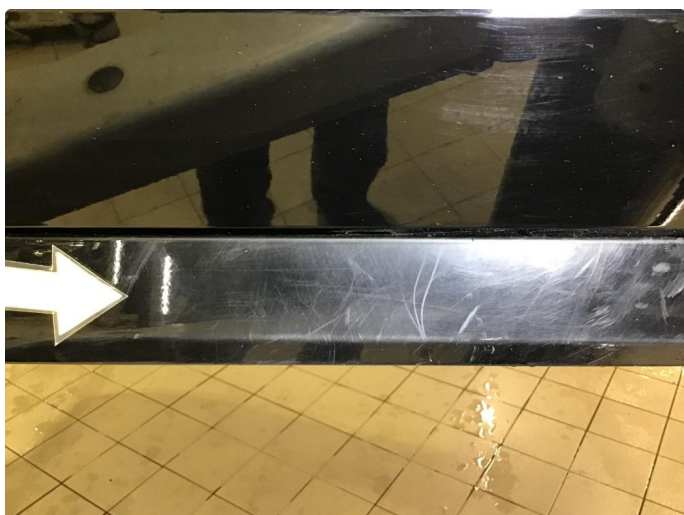
1.6 Noe bruksmerker på kanaler, poleres.
