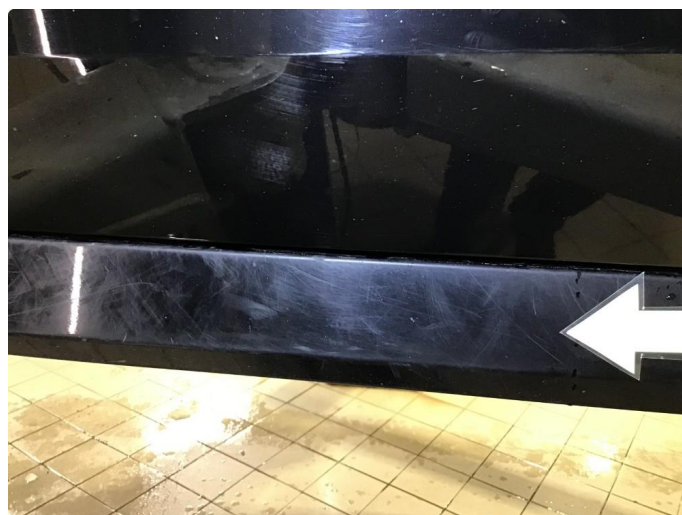
1.6 Noe bruksmerker på kanaler, poleres.
