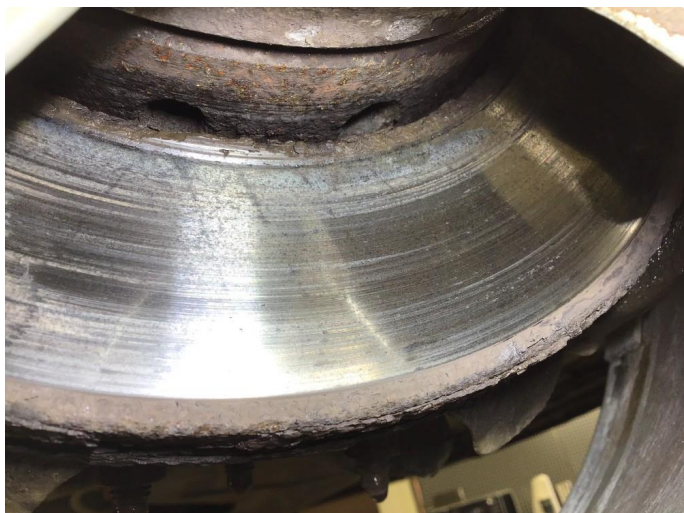
5.1 Noe rust / slitasje bremseskiver fram + bak , bremseklosser målt til 8mm fram + bak.
