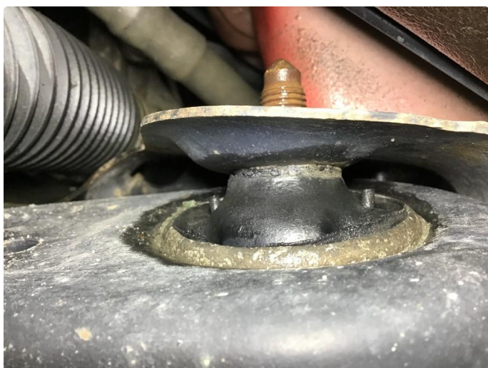
4.2 Slitt bakre bæreamsforing h+v side fram.
