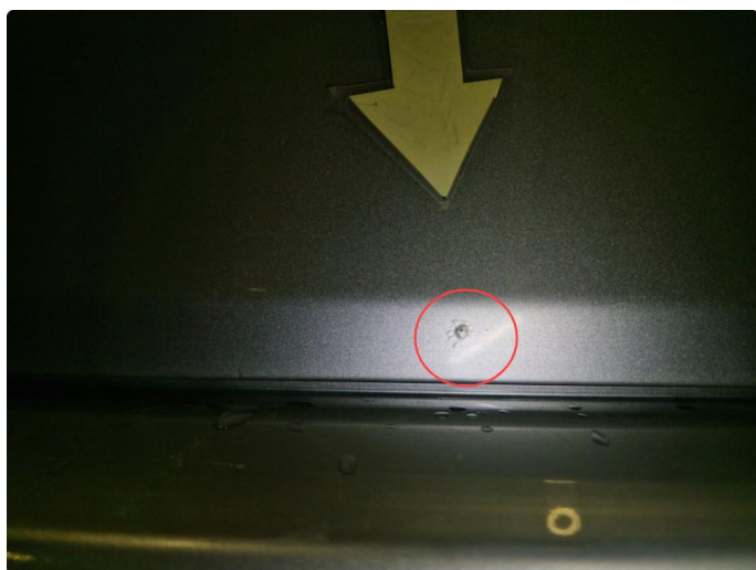
2.7 Rust/korrosjon
