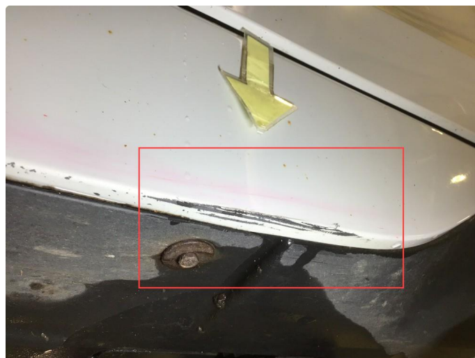
1.8 Noe skrubbermerker underside kanalskjørt v- fram.
