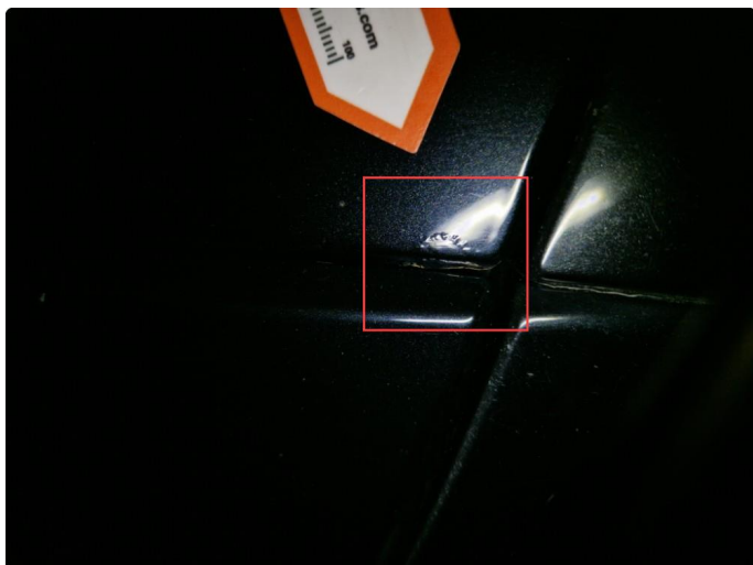
1.4 Rustboble nedre bakre del v-bakdør.
