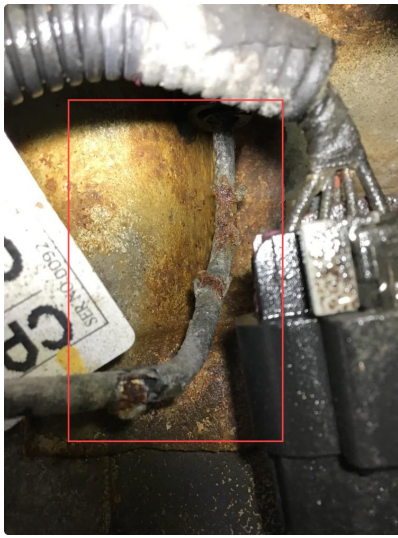
5.2 Rust bremselør h+v side bak + langsgående framover.
