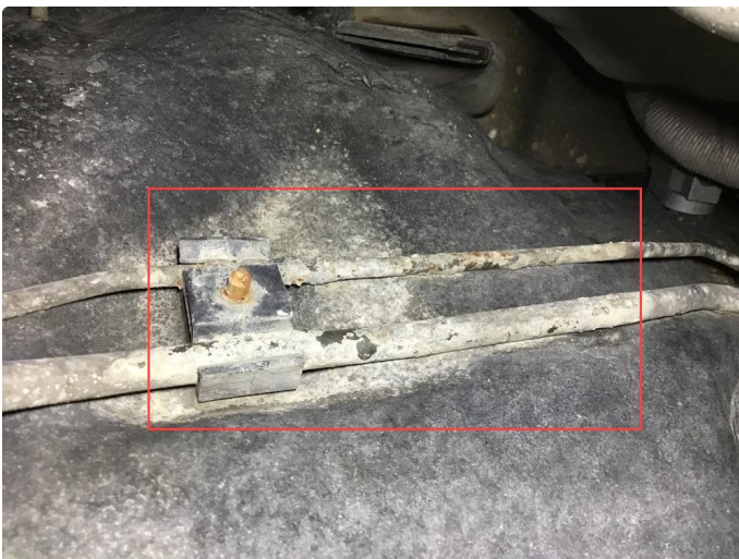
5.3 Rust bremselør langs torpedovegg, mellom h+v side.
