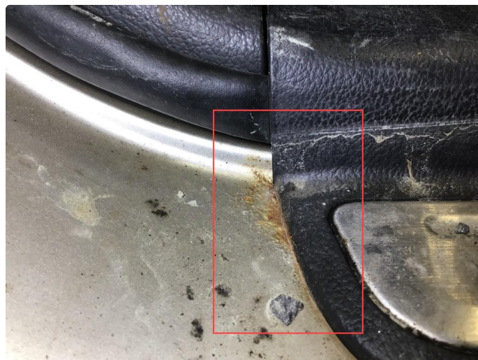
1.11 Rust innsteg h+v bak.
