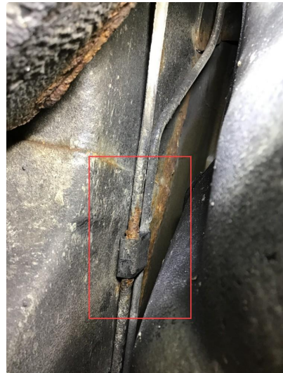
5.2 Rust bremselør h+v side bak + langsgående framover.
