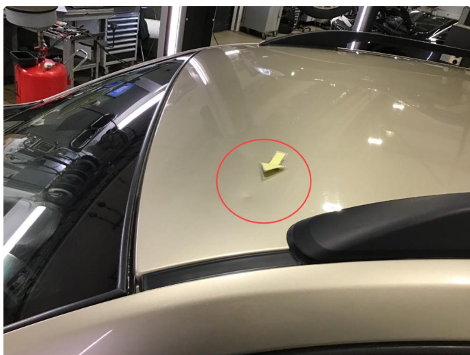
1.13 Rust + bulker fremre del tak.
