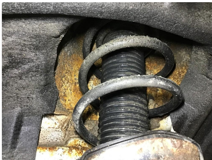
1.2 Noe rust underside + fjærtårn begge sider fremme.
