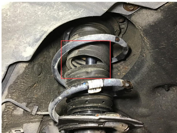
5.1 Sprukket støtdempermansjett h+v fram.
