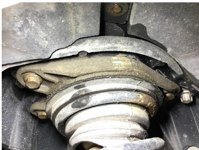
5.1 Fjærbeinslager slitt/defekt. Ulyd / Lugging / treghet fjærbeinslager h+v side fram.
