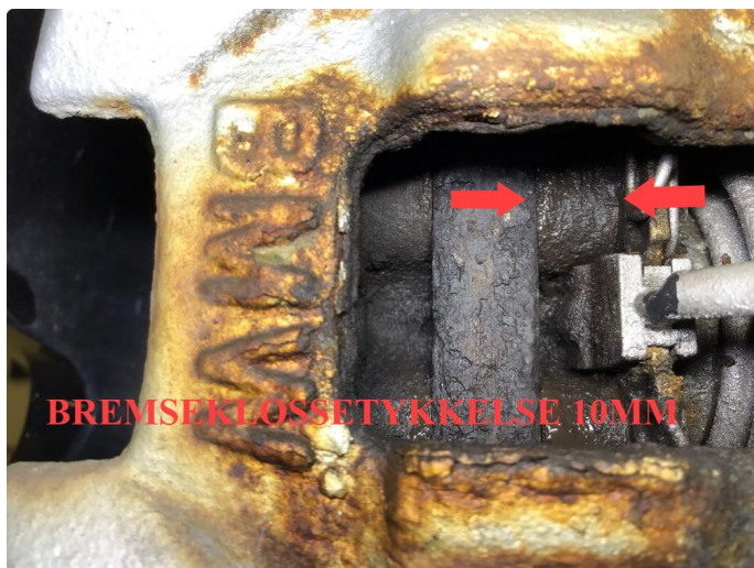
6.1 Rust bremseskiver bak , bremseklosser målt til 10mm.
