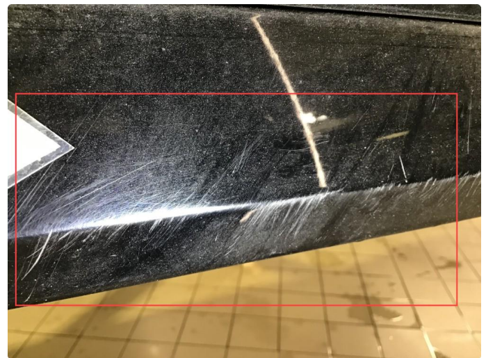
1.3 Noe bruksmerker på kanal, poleres.
