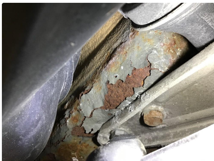
2.2 Rust underside bil ved bakstilling.
