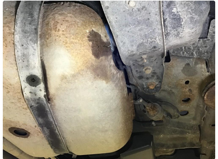
1.1 Noe rust ved bakstilling + deksel rundt drivstofftank.
