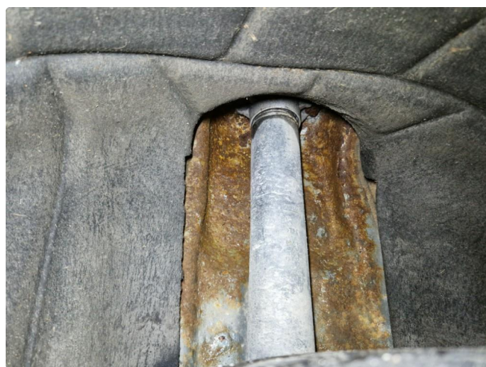
2.1 Rustdannelser underside bil.
