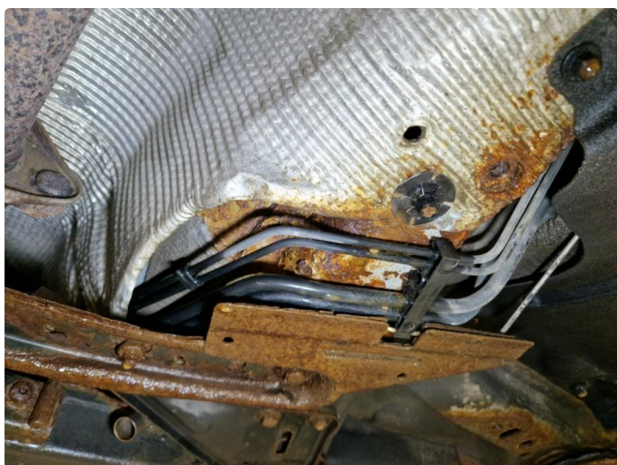
2.1 Rustdannelser underside bil.
