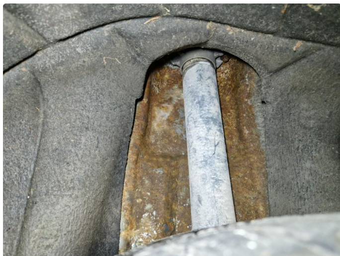
2.1 Rustdannelser underside bil.
