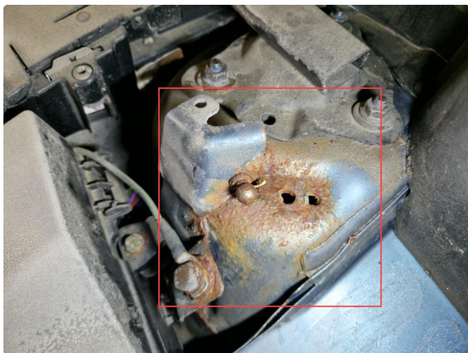
2.2 Rustdannelse dempertårn h+v side fram.
