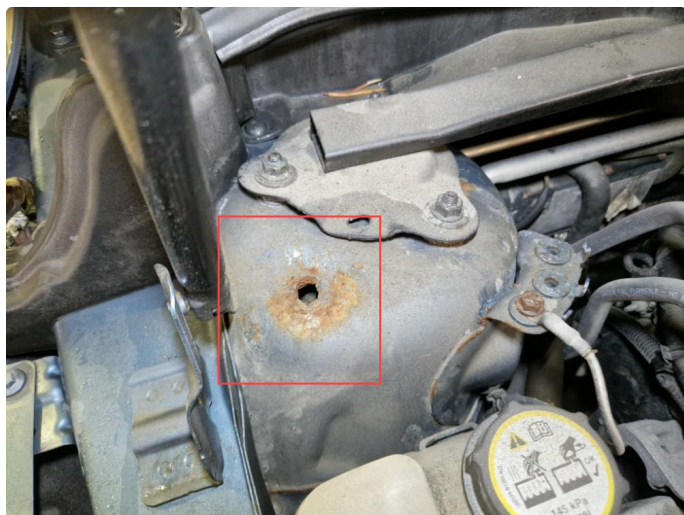
2.2 Rustdannelse dempertårn h+v side fram.
