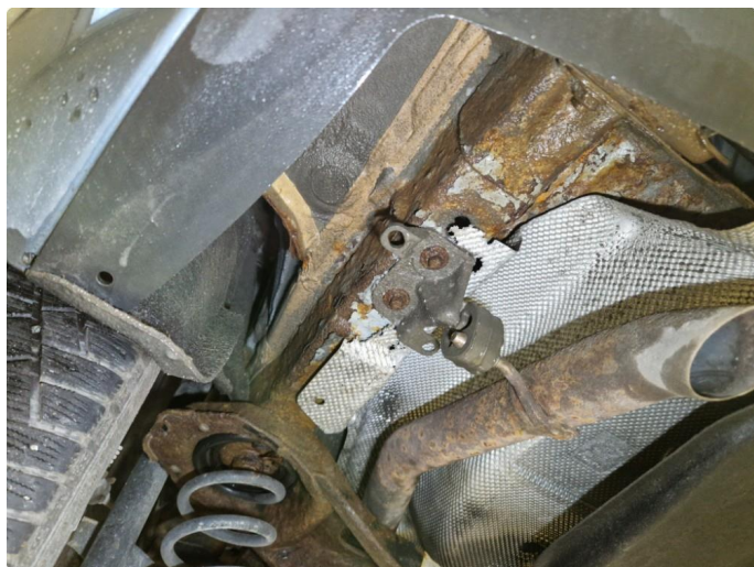
2.1 Rustdannelser underside bil.
