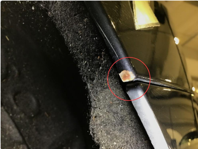
1.1 Steinsprut hjulbue / baksjerm v-bak , normal bruksslitasje.
