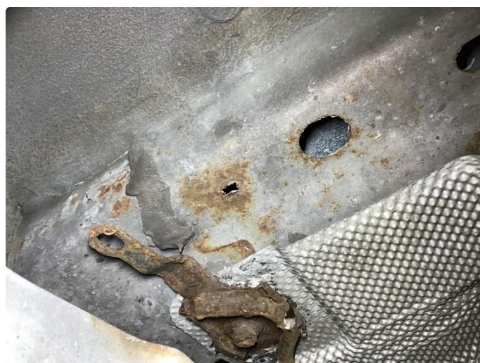
2.1 Rust underside ved bakstilling.
