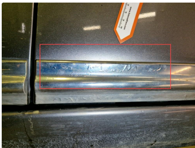
1.6 Korrosjon nedre chromelist alle dører.
