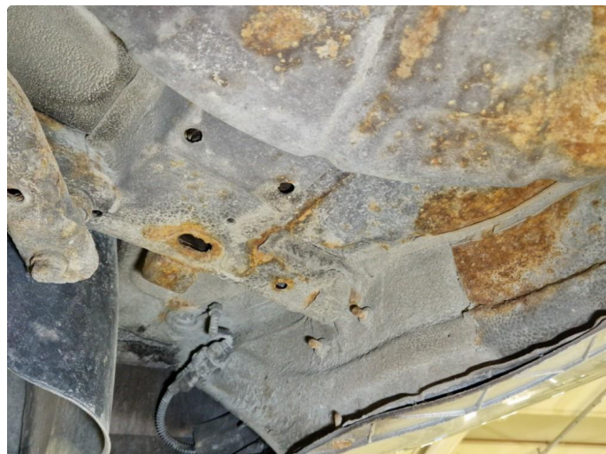
1.1 Noe rustdannelser ved bakstilling.
