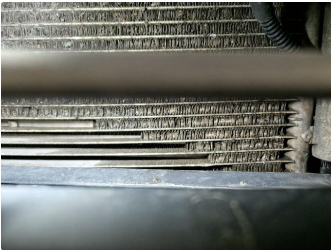
7.1 Skadet / mangler flere kjøleribber AC-radiator.
