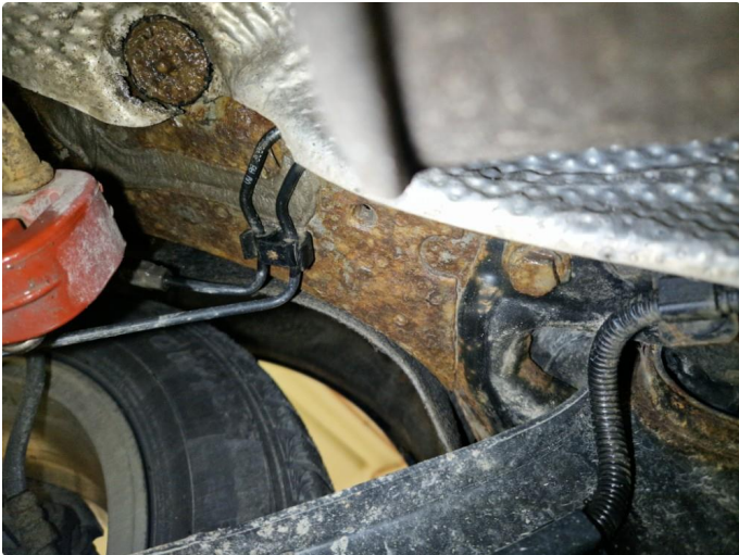
1.1 Rust underside bil ved bakstilling.
