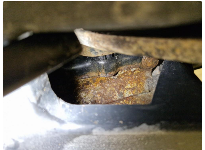
1.1 Rust underside bil ved bakstilling.
