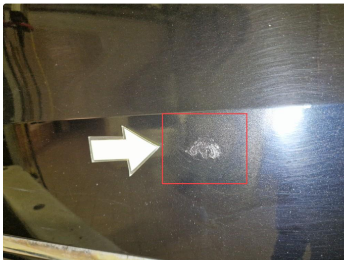
1.4 Rust h+v bakdør.
