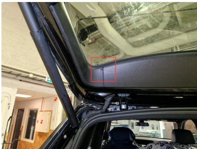
2.8 Lekkasje bakluke, trolig gjennom midtre bremselykt.
