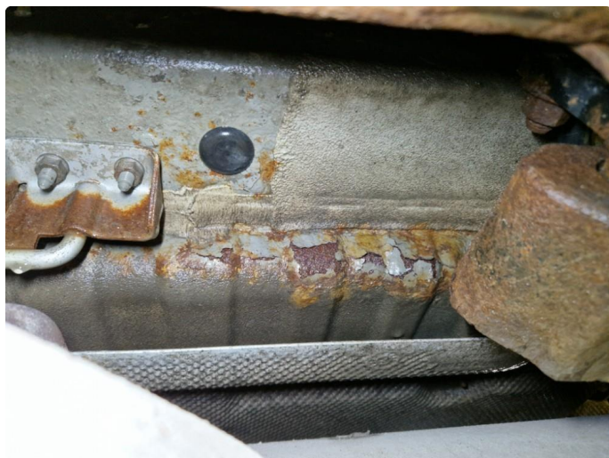
2.1 Noe rust underside ved bakstilling.
