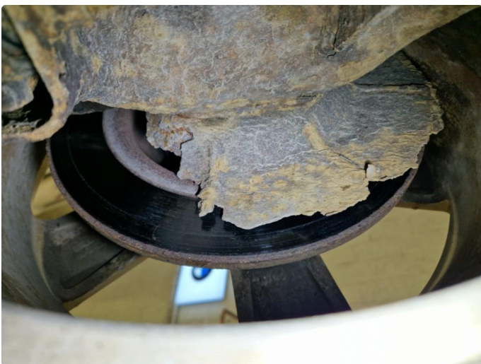
5.2 Gjennomrustet bremseskjold h+v side bak.
