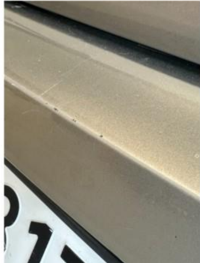
1.3 Noen små hakk i lastesone fanger bak. Lakkeres forenklet
