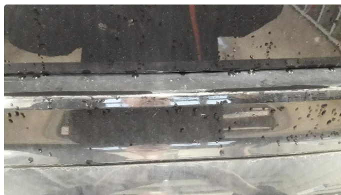
1.4 Ripe(r) ned til grunning (Reparert)
