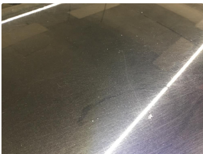
1.2 Noe steinsprut m/rustutslag panser.
