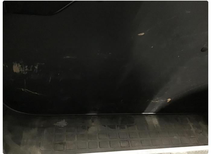
1.1 Skade på deksel i varerom
