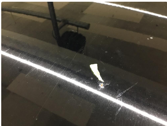
1.3 Noe steinsprut m/rustutslag på taket.
