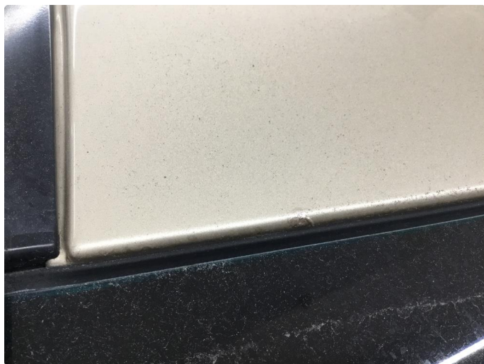
1.8 Noe lakkrust/bruksslitasje.
