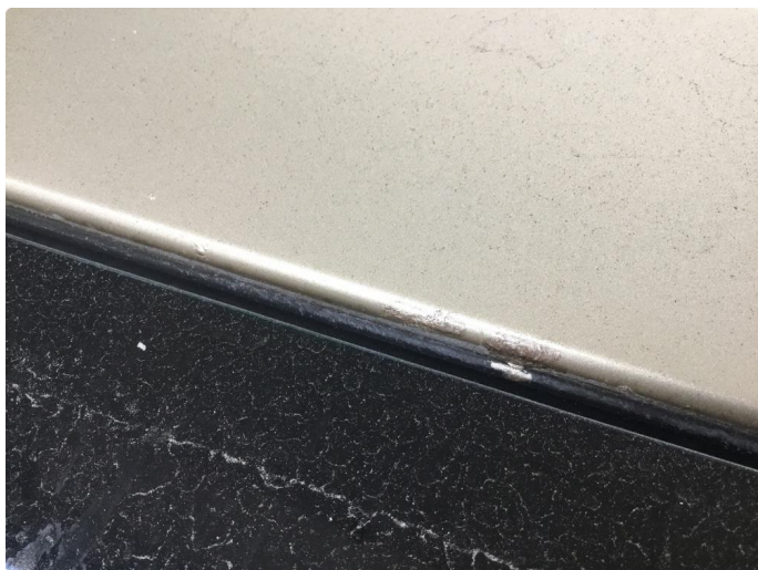
1.8 Noe lakkrust/bruksslitasje.
