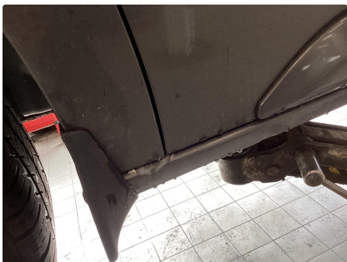
1.6 Ufagmessig utført arbeid
