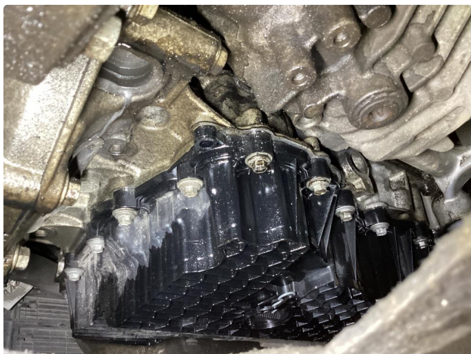
3.1 Oljelekkasje fra motor
