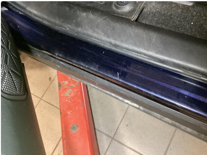
1.1 Noe riper i innsteg
