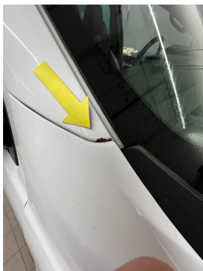
1.4 Lakk flasser A-stolpe høyre.
