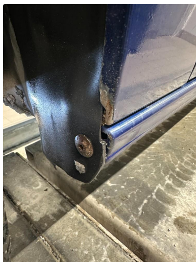
1.3 Rorosjon hjulbue begge sider foran.
