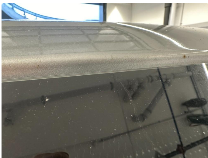
1.5 Steinsprut framkant tak.
