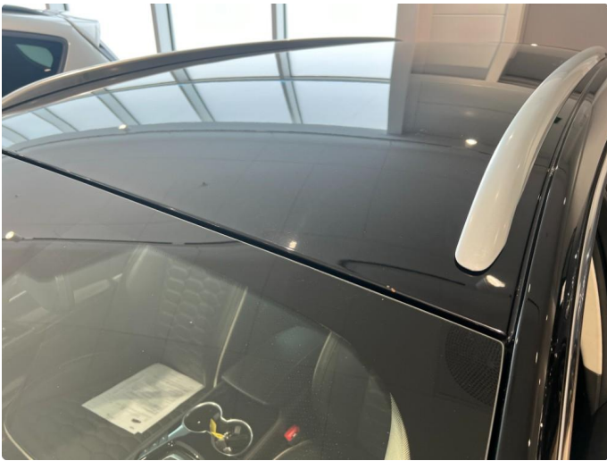
1.9 Steinsprut med korrosjon framkant tak.
