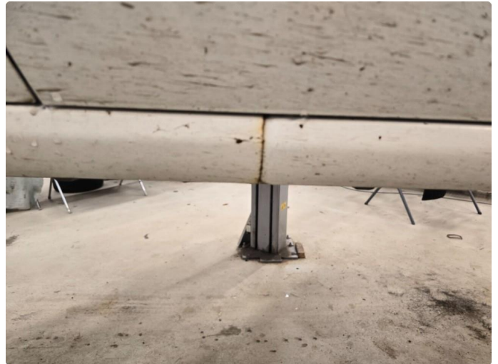
1.1 Noe korrosjon/rust
