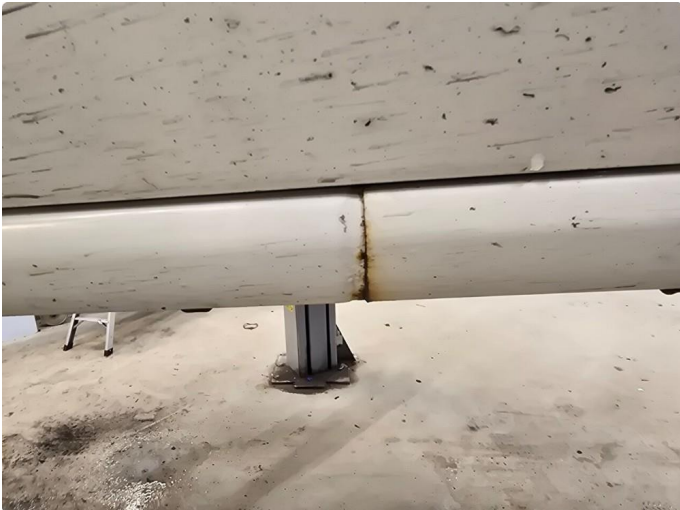
1.1 Noe korrosjon/rust
