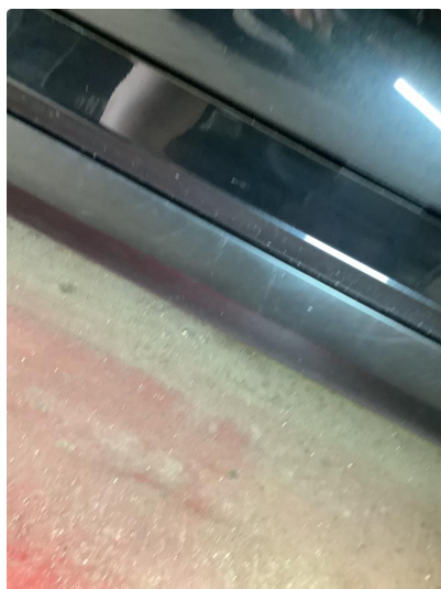
1.1 Noen riper og småbulker
