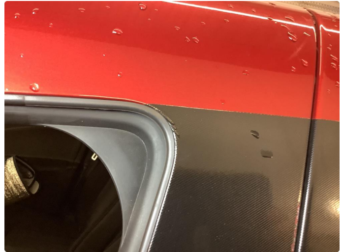
1.1 Generelt mye bruksslitasje
