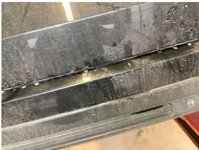
3.1 Generelt mye bruksslitasje
