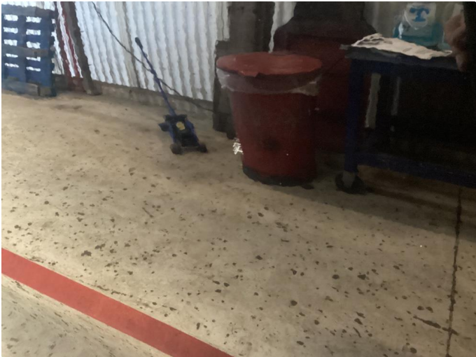
1.3 Ripe ned til grunning
