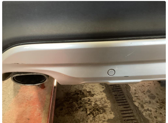
1.1 Skade i plast
