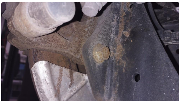
3.1 Rust på bremsler bak - Byttes
