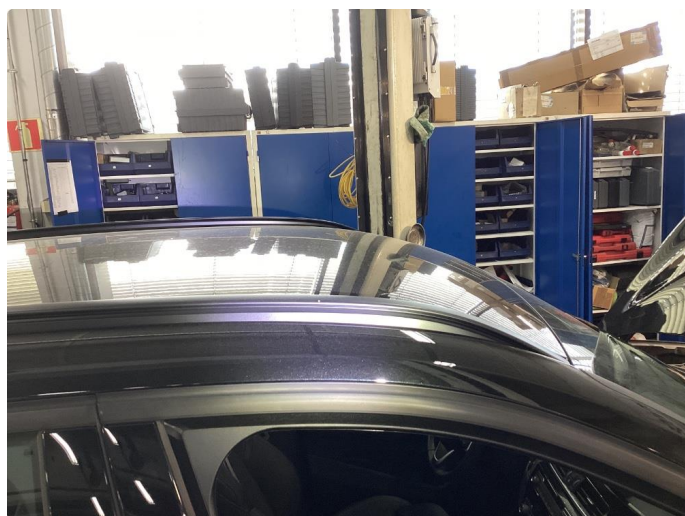
1.4 Liten skade etter bruk av takstativ
