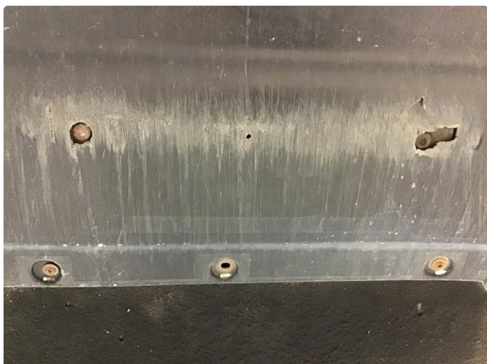
1.1 Beskyttelsesplate skadet/mangler
