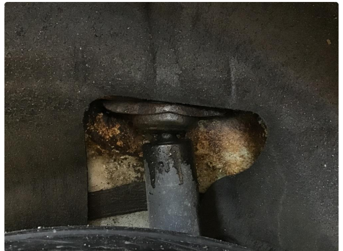
1.2 Begynnende rust i støtdempertopper bak
