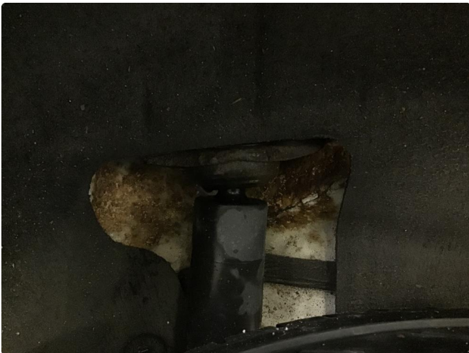
1.2 Begynnende rust i støtdempertopper bak
