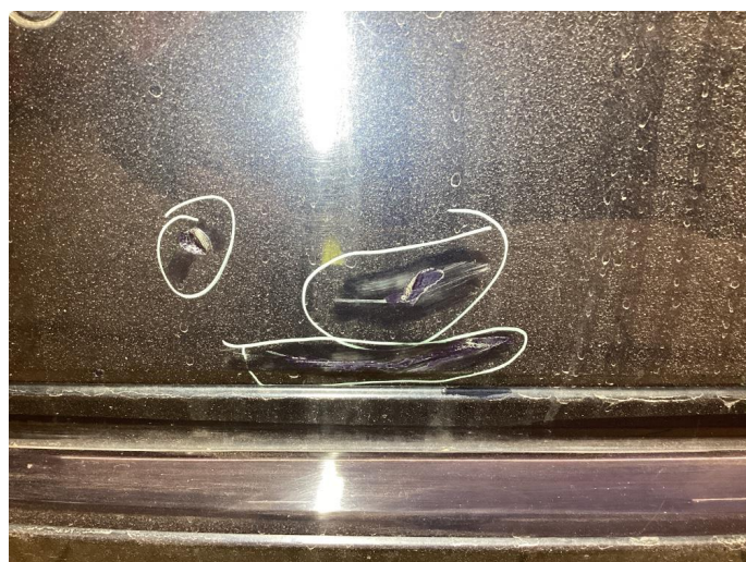
1.6 Ufagmessig utført arbeid
